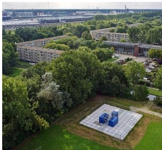
Power2Gas-installatie in Rozenburg met de waterstofinstallatie (blauwe containers) en het appartementencomplex (links) dat met waterstof wordt verwarmd.
